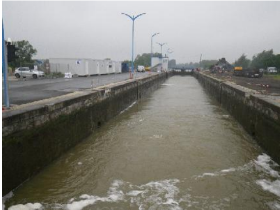
Figure 2-6 : Sas de l'écluse - partie amont
