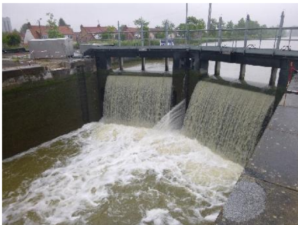
Figure 2-10 : Surverse sur la porte amont
