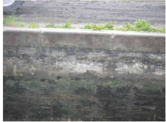
Figure 3-5 : Poutre de couronnement
