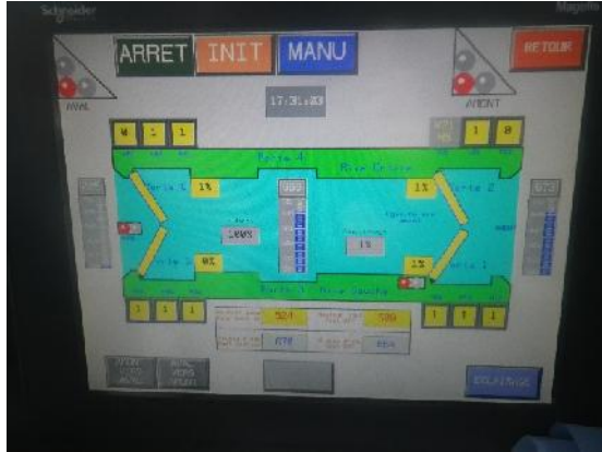
Figure 2-17 : Pupitre de commande indiquant l'état de l'écluse
