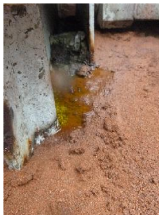
Figure 3-8 : Fuite de la centrale à huile en amont rive gauche
