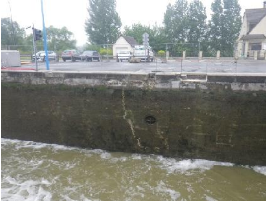
Figure 3-4 : Fissures sur un bajoyer de l'écluse
