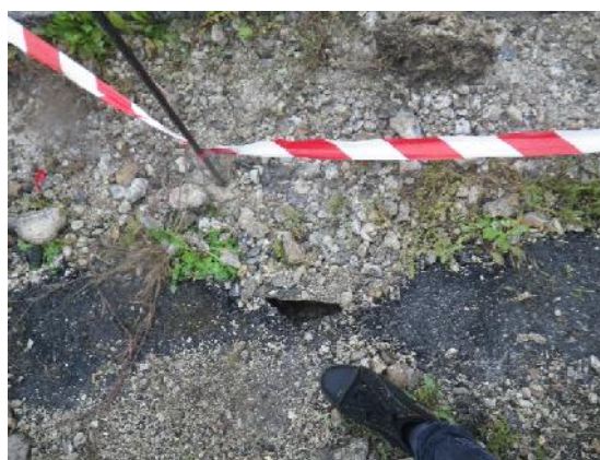
Figure 3-3 : Trou le long du bajoyer rive droite
