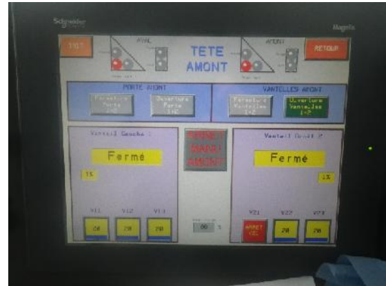
Figure 2-18 : Commande manuelle des vantaux et vannes
