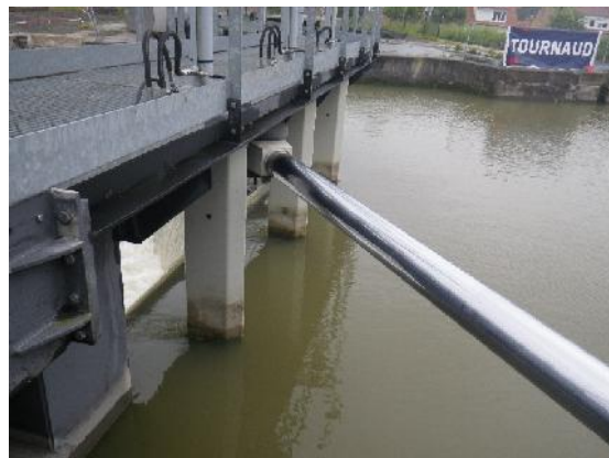
Figure 2-16 : Fixation du vérin au vantail
