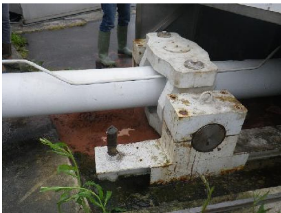
Figure 3-8 : Fuite de la centrale à huile en amont rive gauche
