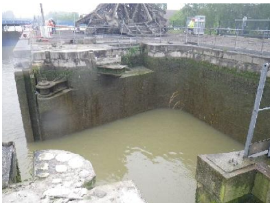
Figure 2-2: Chambres des vantaux de la porte intermédiaire
